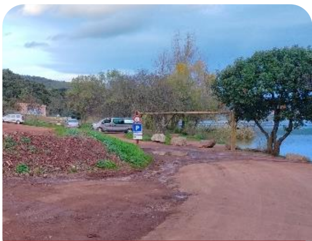
Installation d'un portique au parking de la Borne, Octon - novembre
