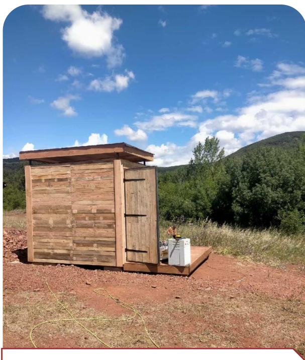
Installation de toilettes sèches sur le pôle des Vailhès, les plages d'Octon et de l'Ariole pour la saison - juin
