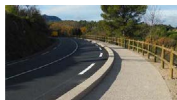
Réalisation de la 1ère tranche de la piste cyclable reliant Clermont l'Hérault au lac Été-automne 2020
