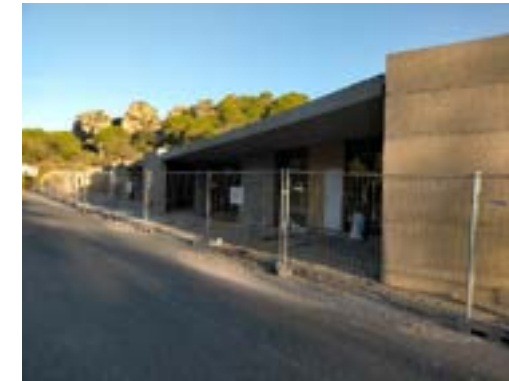
Avancée des travaux de la maison du Grand site Mourèze
