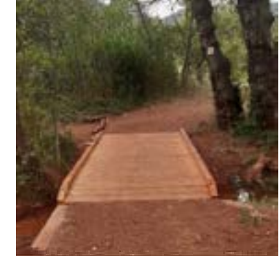
Création de deux passerelles pour permettre le franchissement des cours d'eau Domaine départemental
