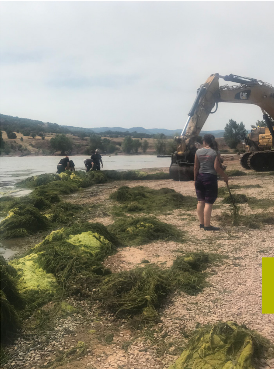
Chantier de lutte contre l’herbier exotique envahissant Lagarosiphon major ((Ridl.) Moss, 1928)
