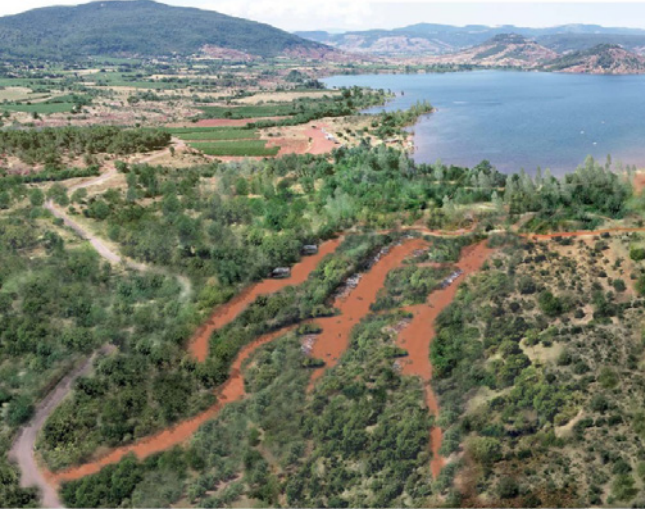
Aménagements paysagers du Pôle d'Accueil et Construction d'une Maison du Site du Salagou
