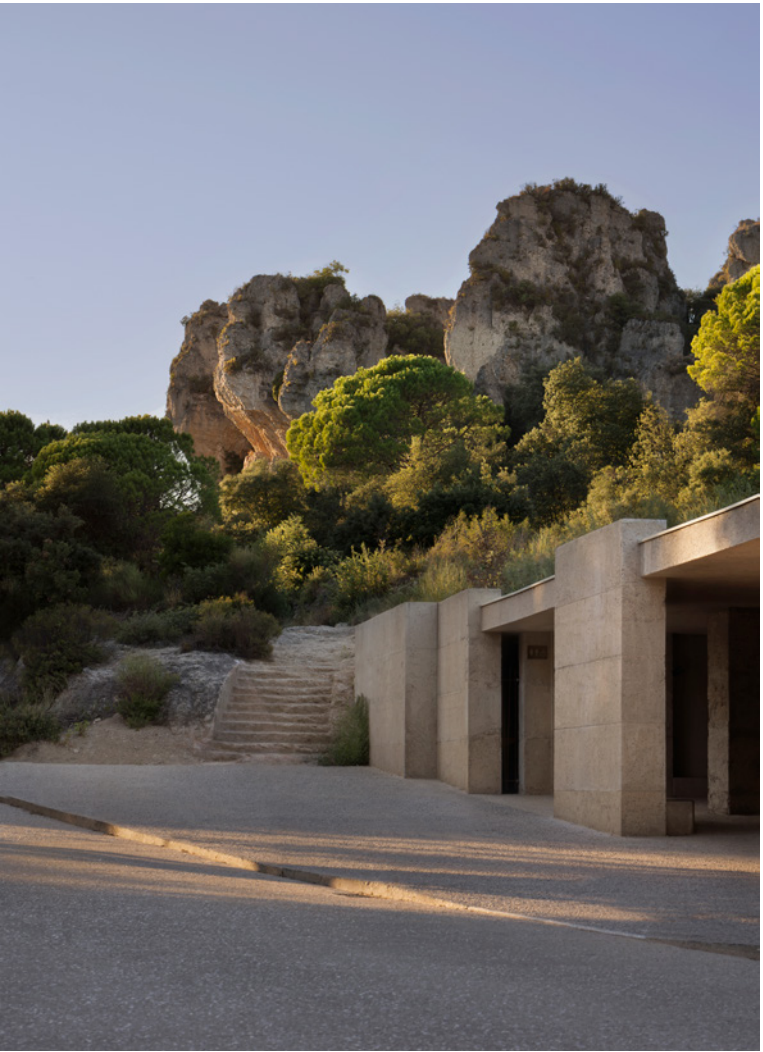
Maison du Grand Site à Mourèze
