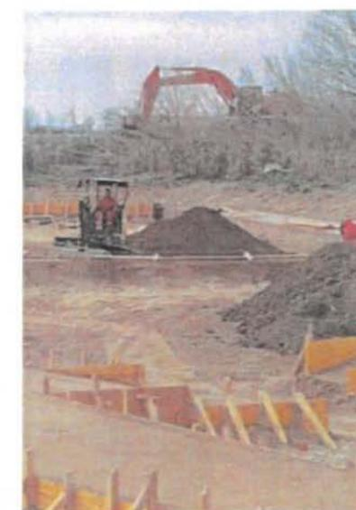
3/ Une semelle de propreté sera coulé en place ainsi qu'une dalle béton de 0.10m afin de recevoir le coffrage et l'ouvrage. Des piliers en béton préfabriqué seront implantés et scellés dans ce béton.
