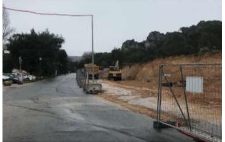
Requalification du pôle de Mourèze : lancement des travaux Mourèze – novembre 2020
