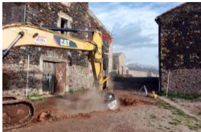
Chantier de viabilisation du village ; raccords en électricité, eau et assainissement Celles - 2020
