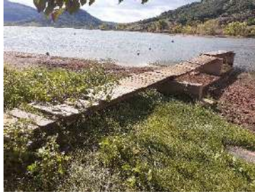
Dépose du vieux ponton Les Vailhès - octobre
