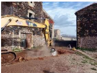
Viabilisation du village de Celles Raccordements en électricité, eau et assainissement.
