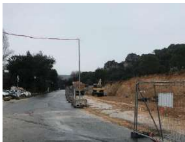
Lancement des travaux d'aménagement du pôle d'accueil de Mourèze novembre
