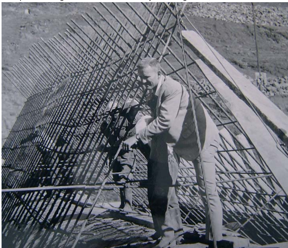
Claude Seeli sur le chantier en 1967
